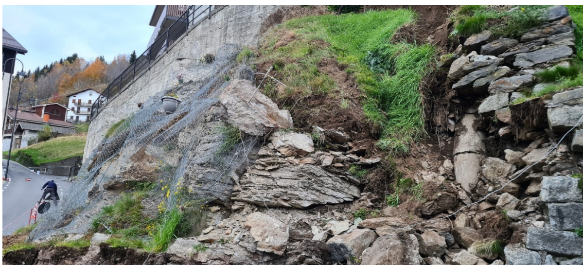
Vista della porzione instabile del versante a monte dell'accumulo di frana.
