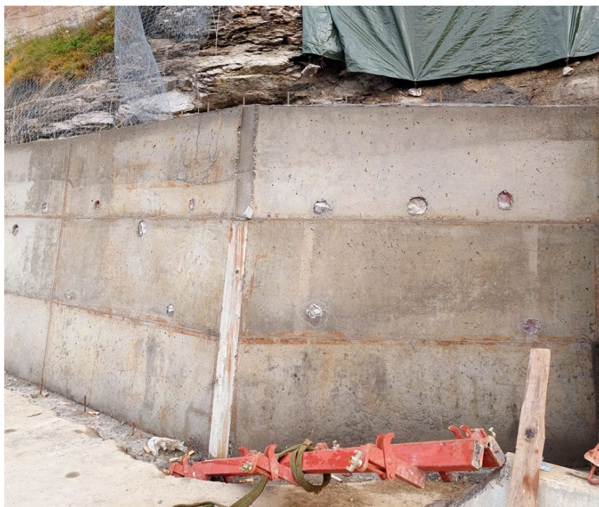
Realizzazione di opere di sostegno tirantate.
